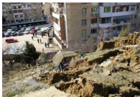
Рис. 2. Оползневые процессы в Хатаинском районе г. Баку (фото 3 марта 2012 г.)
